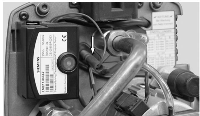
Abb. 20: Ionisationskabel mit Stecker
